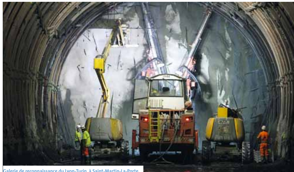
Galerie de reconnaissance du Lyon-Turin, à Saint-Martin-La-Porte.
