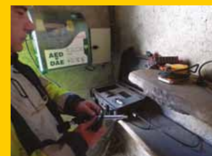
▲ Installation des capteurs sismiques
