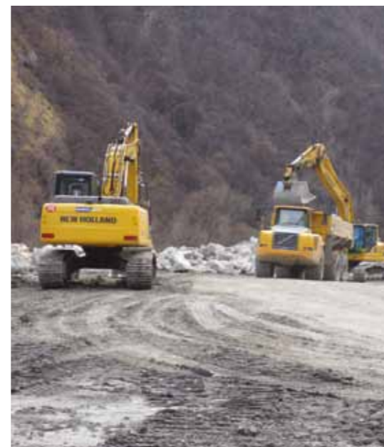
▲ La réalisation des enrochements d'un des sites de dépôts a été confiée à des entreprises locales
