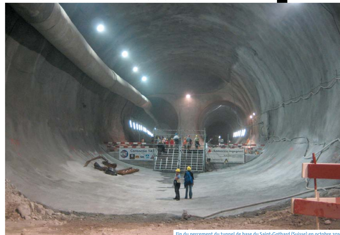
Fin du percement du tunnel de base du Saint-Gothard (Suisse) en octobre 2010.
