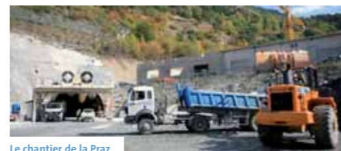
Le chantier de la Praz
