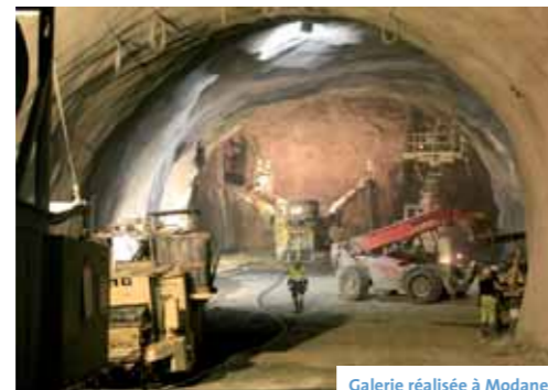
Galerie réalisée à Modane
